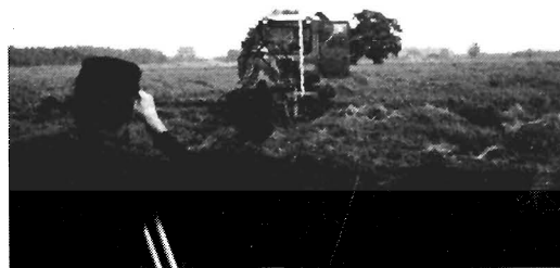
Kuva 4. Myyräsalaojitusmenetelmässä salaojan syvyys ja kaltevuus säädetään vaaituskoneen ja kauko-ohjauksen avulla.
