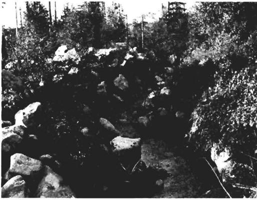
Kuva 4. Traktorikaivurilla ilman räjäytysaineita avattu kivinen kynnyks, kaivuvaikeusluokka 5. Kaivuvaikeusluokat 4 ja 5 esiintyvät yleisesti metsäojitustyömailla laskuojien alapäässä leikattaessa tiivistä tai kovaa pohjamoreenia.
