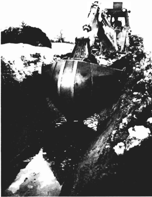
Kuva 1. Metsäojituskaivuri tekemässä ojaa vähäpuiseen turvemaahan. Ohut lumi- ja routakerros eivät haittaa lainkaan konekaivua, kaivuvaikeusluokka 1.
