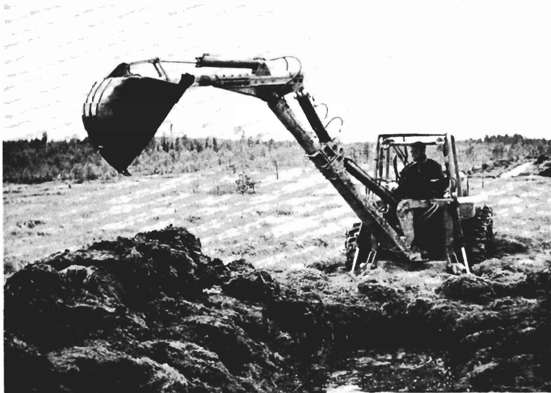
Kuva 3. Laskuojan kaivua sulan maan aikaan upottavalla avosuolla. Työ käy vielä ilman telapuita, joten kaivu- vaikeusluokka on 3. Lievän roudan aikaan kaivu- vaikeusluokka saattaisi olla 1–2. Teettämällä konekaivu opti- miolosuhteissa järjestelystä hyötyvät sekä urakanantaja että urakoitsija.
