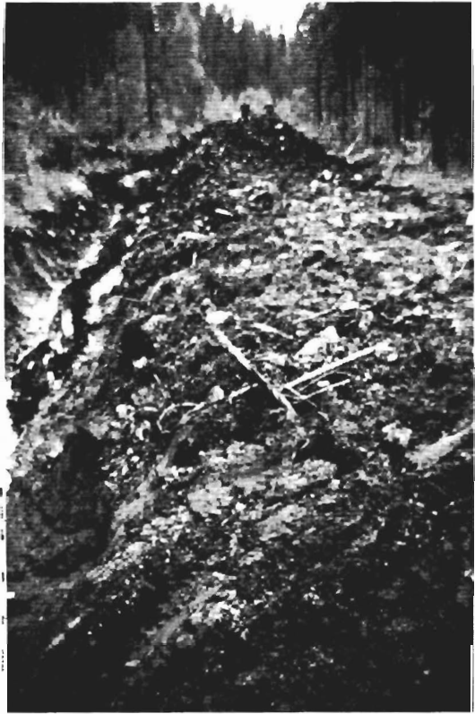
Kuva 3. Ohutturpeisella suolla saadaan ojasta kivennäismaata piennartasanteen runkoon, jolloin siitä tulee huomattavasti kantavampi kuin paksurpeisella suolla. Tällöin on kuitenkin jo kaivuvaiheessa nostettava kivet ja kannot ojan vastakkaiselle reunalle, jotta ojamaiden levitys ja tasaus ei muodostuisi kovin työlääksi.
