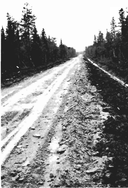
Kuva 1. Syväturpeiselle suolle on tehty VI luokan varsinainen metsäautotie. Perusparannus- ja metsänhoitotie tulee läheisesti muistuttamaan tällaista tietä, joskin se jää rakenteeltaan vielä kevyemmäksi.
