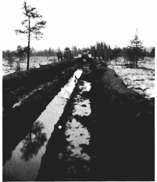
Kuva 2. Auraajitusta Enso-Gutzeit Osakeyhtiön työmaalla Juuassa.
