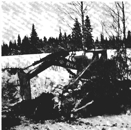
Kuva 3. Saksalaisvalmisteinen keskirkas hydraulinen kaivukone RH 4 työssä. Keskusmetsälautakunta Tapiion ojitustyömaa Rovaniemen mlk. Jaantila. Kaivukone pystyi liikkumaan ilman lumen esiaurausta vaikka lumikerroksen paksuus oli keskimäärin yli 10 dm.
