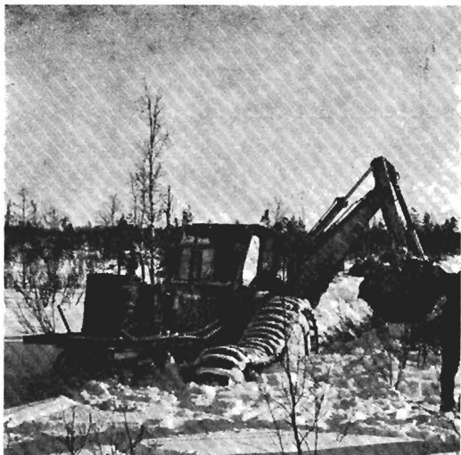
Kuva 2. Kaivuri työssä metsäntutkimuslaitoksen ojitustyömaalla Muhoksella. Suoteloillakin varustetun koneen oli vaikea liikkua lumikerroksen paksuuden ollessa 7—8 dm. Työyksikön käyttötraktori on Nuffield 10/60 ja kaivulaite Ukko-Mestari 3 TL. Kuvat kirjoittajan.
