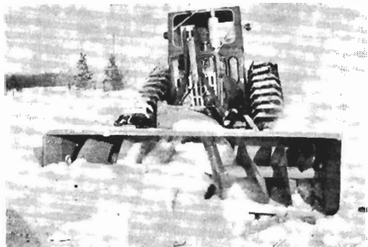
Kuva 7. Kajaanilaisen Meriläisen konepajan valmistama etulinko työssä Nurmeksen mlk:n tutkimustyömaalla. Käyttötraktorina on Ford 5000.
