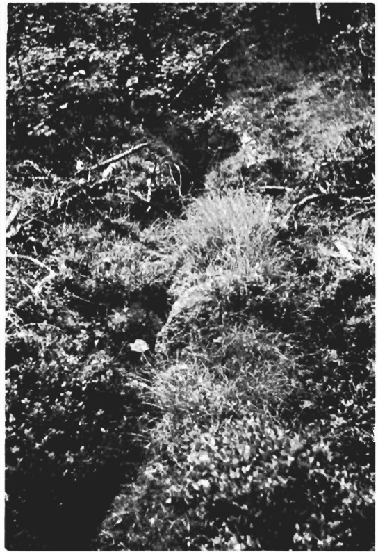
KUVA 4. Noin 28 % vanhoista metsäojista on tällä hetkellä niin pahoin tukkeutuneita, että ne vaativat todella kiireellistä perkausta. Perattaessa ojista joudutaan poistamaan etupäässä turvetta. Sitä paitsi niissä esiintyy suhteellisen vähän kiviä tai muita esteitä — lukuunottamatta joissakin tapauksissa hakkuutähteitä ja ojan reunapuustoa —, jotka suuremmassa määrin haittaavat perkaustyötä.
