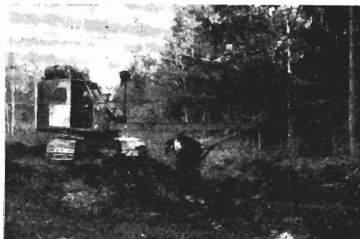
Kuva 1. Kaivinkone E-352 toiminnassa.
