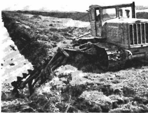
Kuva 7. Viemärin perkausta ojaperkauskoneella D-490.
