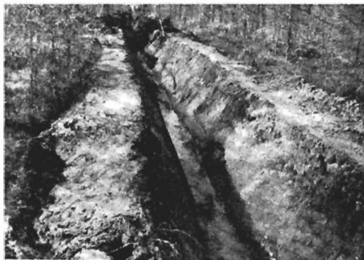
Kuva 1. Ohutturpeisessa hiekkamaassa on auran kärjen kuluneisuus ollut myös osasyynä siihen, että ojan luiskat ovat tulleet liian jyrkiksi ja ojamaat jääneet aivan ojan reunoille.
