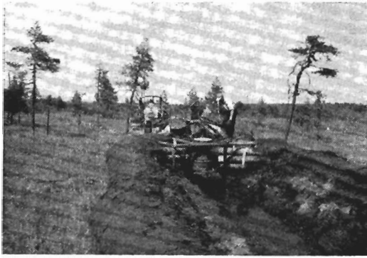
Kuva 2. Löyhässä paksuturpeisessa ojituskoh- teessa on auran peräosa painunut alas, jolloin maita siirtävät siivet ovat repineet pintaturpeen pois ojan reunoista.
