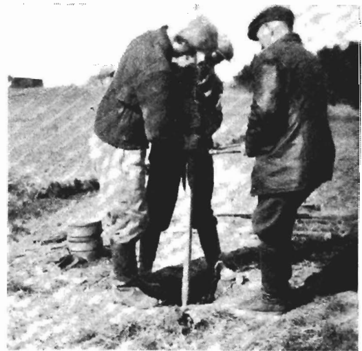
Kuva 4. Maanäytteitä otetaan mäntäkairalla Luhtajoen sortuma-alueella Nurmijärvellä.
