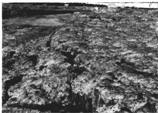
Kuva 12. Liejumaahan kaivettu väylä on sortunut Kirkkojärven pengerrysalueella Liperissä.
