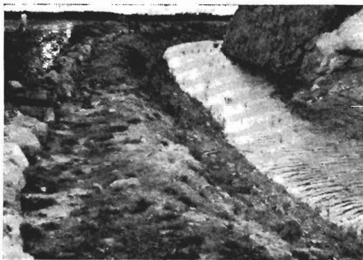
Kuva 15. Pengertämällä kuivatetun Kalliojärven (Tammelassa) eristysoja on louhittu osittain kallioon, koska ojan vasemmalla rannalla oleva penger olisi muutoin jouduttu rakentamaan noin 15 m:n vahvuisen pehmeän liejukerroksen päälle.
