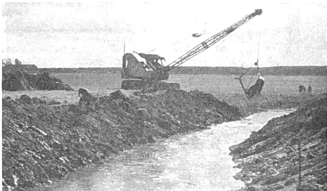
Kuva 1. Link-Belt-merkkinen, 0,4 \text{ m}^3 :n kauhalla varustettu kaivukone valtaojan puhdistuksessa
