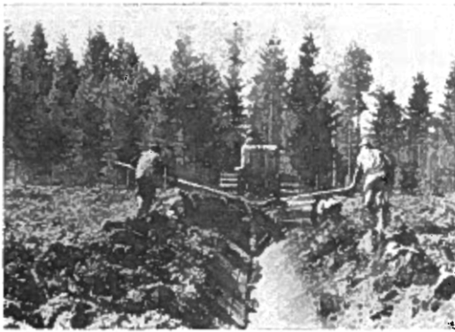
Kuva 3. Uudisojitusta Liitso-merkkisellä auralla kivennäismaalla. Vetokoneena Allis-Chalmers HD 5-merkkinen telaketjutraktori.
