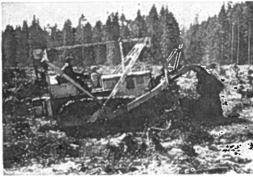
Kuva 4. Caterpillari D 4-merkkinen telaketjutraktori varustettuna kantohangolla kantojen irrotuksessa.
