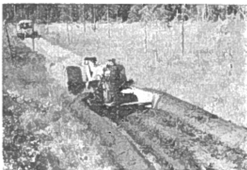
Kuva 2. Pellonraivaus Oy:n rakentama metsäoja-aura.
