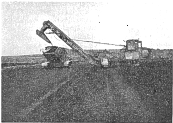
Kokoamiskone kokoo ja kuormaa kuivat turpeet säiliövaunuun.
