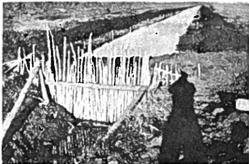
Kuva 2. Veden patoamiseksi valtaojaan rakennettu tilapäispato.
