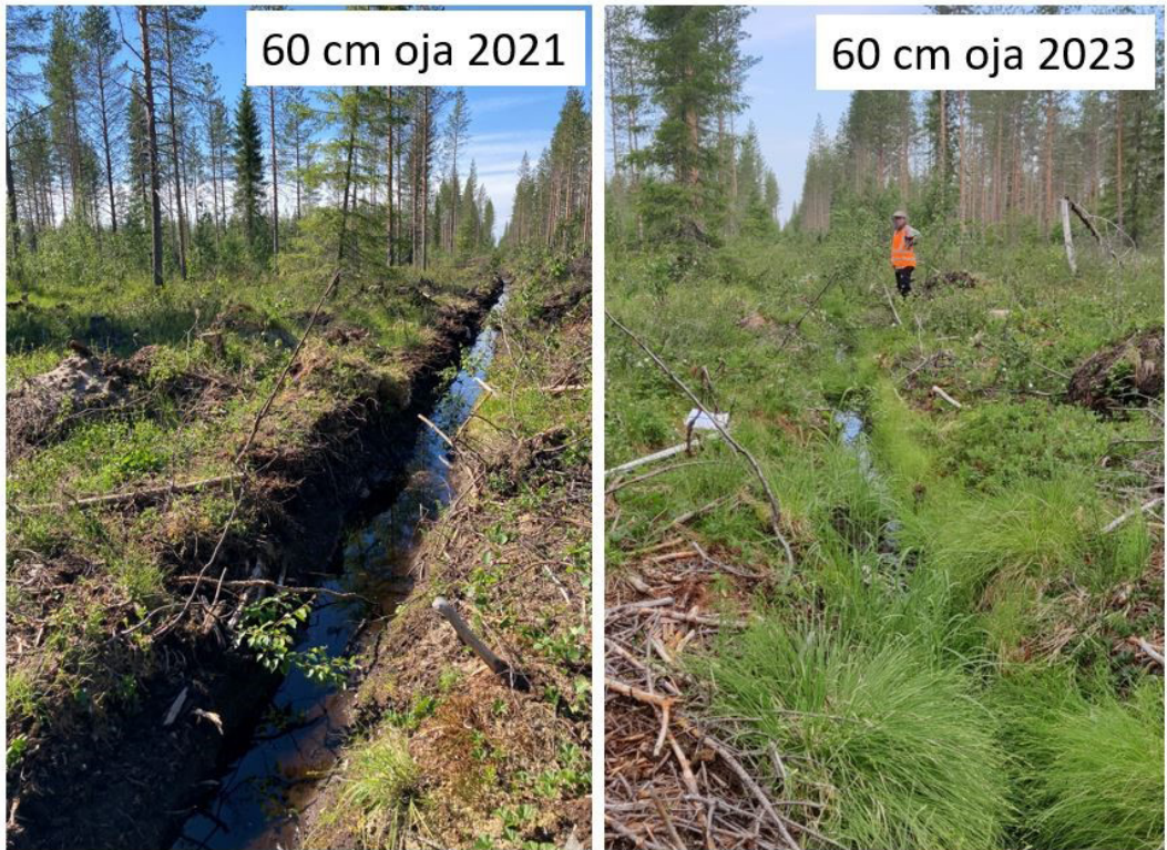
Kuva 5. 60 cm tavoitesyvyyteen kaivettu oja Polvensuolla Pudasjärvellä vuonna 2021 ja 2023. (Kuvat: Maija Kauppila). Figure 5. A ditch dug to a depth of 60 cm at Polvensuo mire, Pudasjärvi in 2021 and 2023. (Photos: Maija Kauppila).
