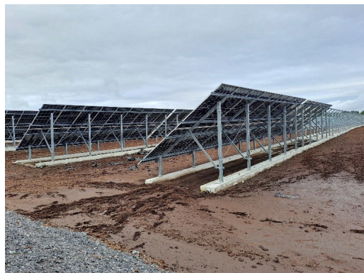
Kuva 3. Aurinkovoimalan perustuksia ja telineitä Lapuan Heininevalla (Kuva: Kari Laasasenaho).
