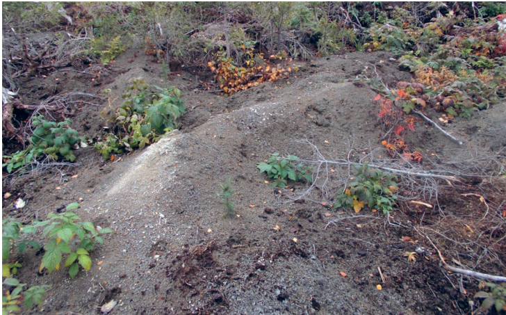
Kuva 5 ylhäällä) Metsänuudistamiskohteella Lounais-Suomessa todettiin hapanta sulfaattimaata ojan pohjassa. alhaalla) Ojan kunnostuksen yhteydessä nostettua pohjamaata on kasattu istutusmättäiksi. Kuvat: Timo Silver, Suomen metsäkeskus.
